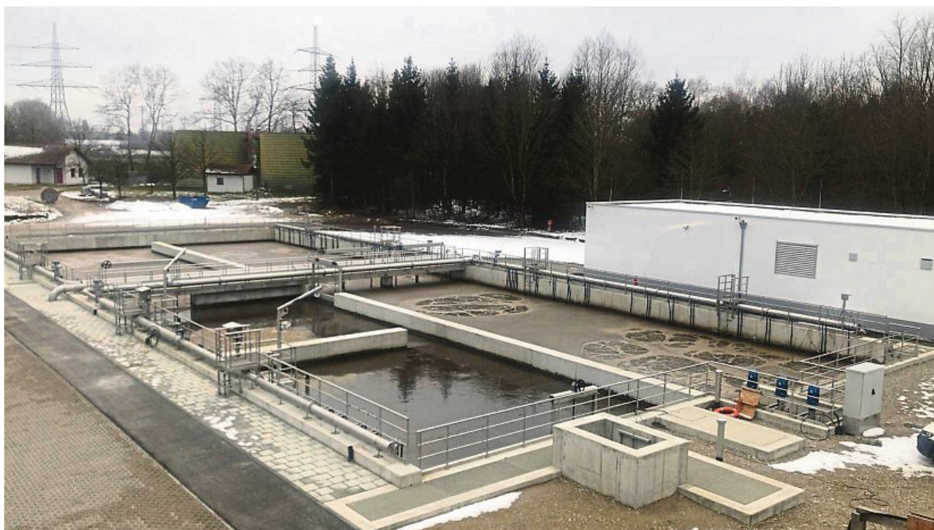
Baustelle im Wandel der Monate: Das Bild links oben zeigt den Beginn der Arbeiten im Sommer 2019, ein Jahr später war der Baufortschritt dort schon deutlich zu erkennen (oben, r.). Auf dem Foto unten ist das fertige neue Belebungsbecken vor wenigen Tagen zu sehen.
